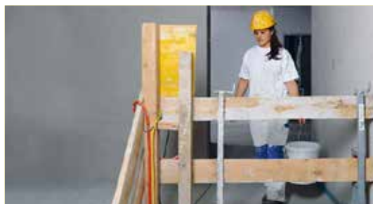
Baustellen müssen immer gut abgesichert werden. FOTO ZVG
